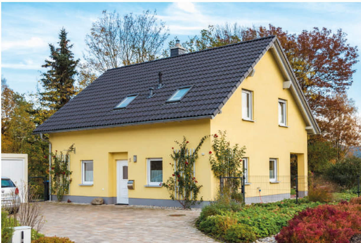
▲ NEUBAU - EFH - Flöha
