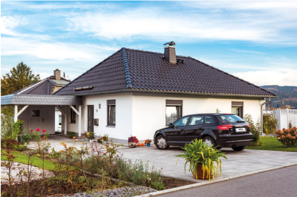
▲ NEUBAU - EFH - Flöha
