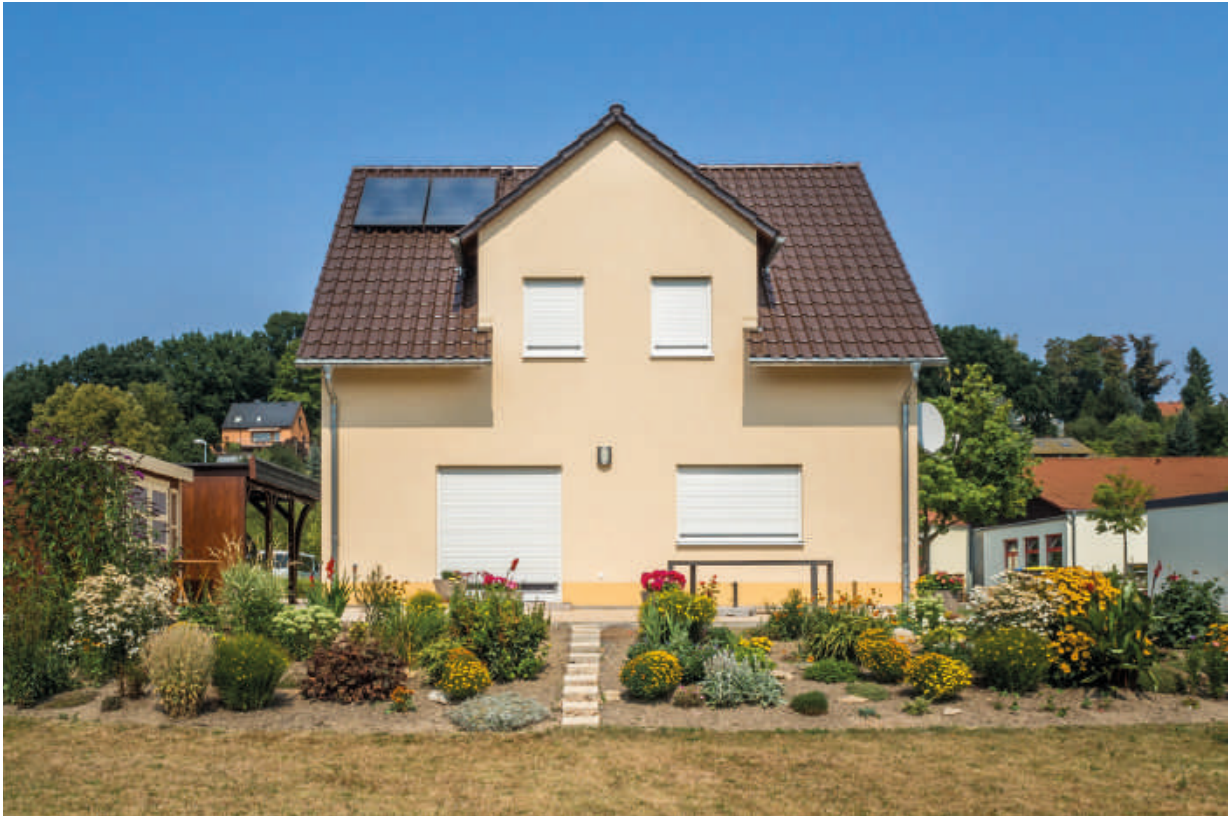
▲ NEUBAU - EFH - Flöha
