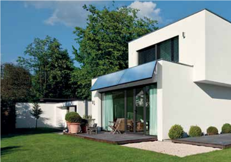
Solar-Flachkollektoren in Fassadenmontage
